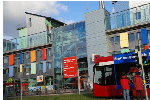
Figure 6 - Le centre commercial à toitures PV.
