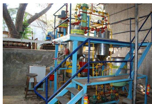
Figure 3 - Prototype d'usine rurale de transestérification des huiles végétales pour en faire du biodiesel
