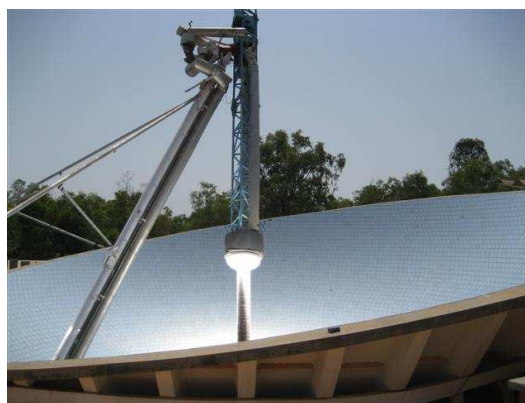
Figure 11 - Miroir parabolique et serpentin chauffant (cuisine solaire d'Auroville).
