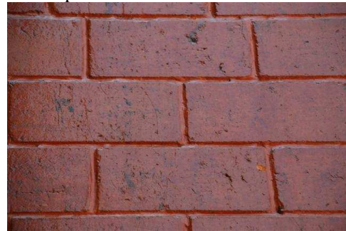
Figure 7 - Mur de latérite, roche remplaçant avantageusement la brique en climat tropical (T-ZED, Bangalore).
