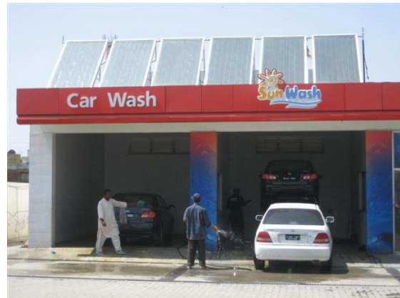
Figure 2 – Chauffe-eau solaires de SunWash, à la station Total Parco de Rawalpindi (banlieue d'Islamabad)
