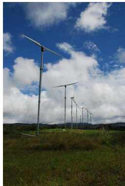
Figure 9 – Deux éléments sont à noter : 1. la base en forme de L à l'envers, permettant le treuillage 2. L'utilisation d'une hélice bipale.
