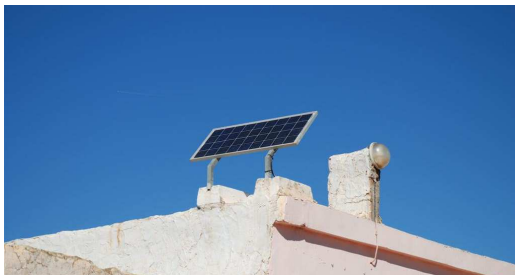
Figure 3 – panneau installé par Témasol, kit de 50 Wc
