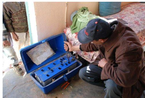
Figure 4– visite de contrôle d'un technicien de Témasol (vérification des niveaux de l'électrolyte)
