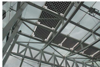
Figure 2 – Le public exemplaire : une tonnelle de cellules solaires éclaire le dernier étage des bureaux de l'EMSD, en limite l'échauffement et produit de l'électricité.
